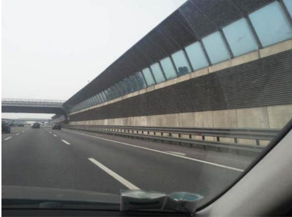
**Abb. 6: Abbildung einer abgewinkelten Lärmschutzwand**
