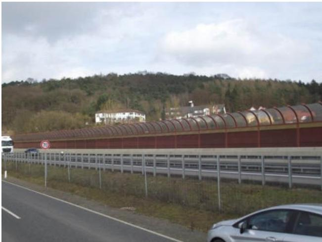
**Abb. 5: Abbildung einer gekrümmten Lärmschutzwand**
